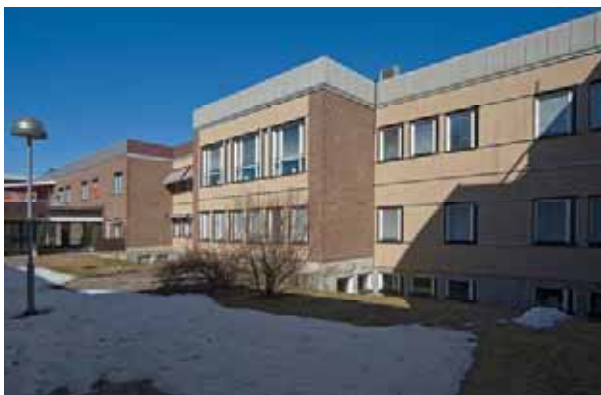
Överst: Entré i norr . Nbm acc.nr. 2010:163:0138 Mitten: Husen är byggda i souterräng, vy från väster. Vid entré, hus 104 till höger i bild. Nbm acc.nr.2010:163:0122 Nederst: Burspråket på entrébyggnaden mot innergården. Fasad klädd med Steniplattor och tegel. Nbm acc.nr. 2010:163:0003
