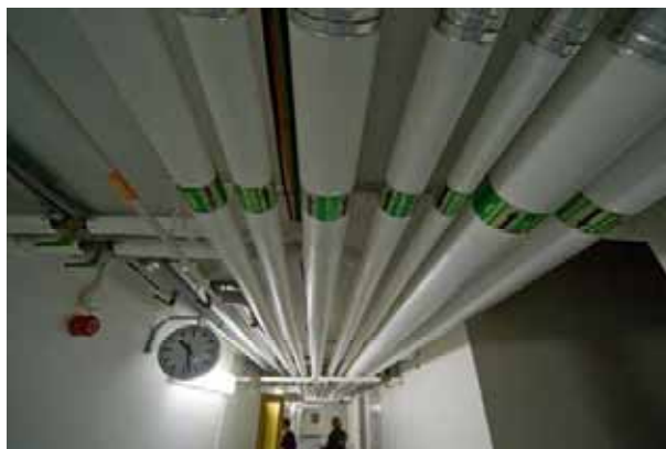
Överst: Kapprum f.d. matsal. Hus 103. Nbm acc.nr. 2010:010:0075 Mitten: Filmvisningsrum och ljusterapirum. Nbm acc.nr. 2010:010:0129, 2010:010:0123 Nederst: Rörledningar i taket i källarkorridoren hus 103. Nbm 2010:010:0127
